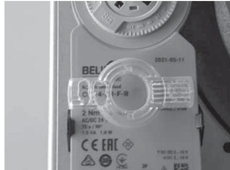
Abb. 3.31 Kupplung entriegelt
