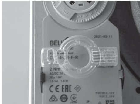
Abb. 3.19 Kupplung entriegelt
