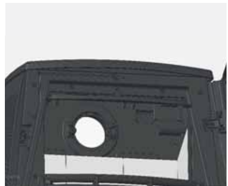
Abb. 4.22 Reinigung der Heizgasführung
