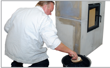
Lacryl Tiefgrund ELF 595 gleichmäßig auftragen.
