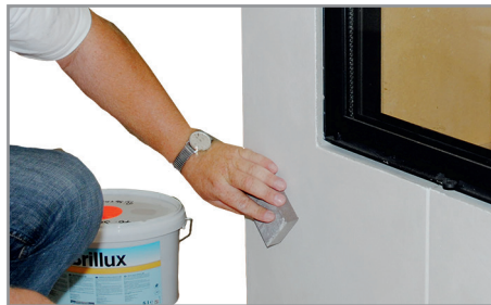
Unebenheiten nach dem Trocknen mit dem Schleifschwamm angleichen.
