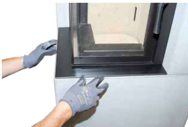
23. Bankplatte auf das Unterteil setzen und unter die Traverse schieben. Bankplatte ausrichten.
