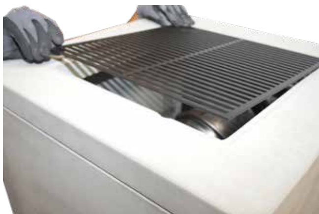
22. Deckengitter in die vorgesehene Öffnung einsetzen.
