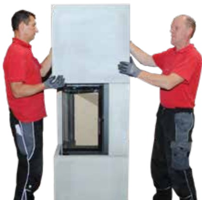
19. Oberteil ohne zu verkleben von oben auf die Seitenteile setzen. Untere Steg kann bei Aufbau mit Ekko 34(34)57 h entfernt werden.
